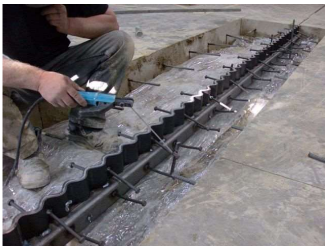
1 Сурет - Деформациялық жік
